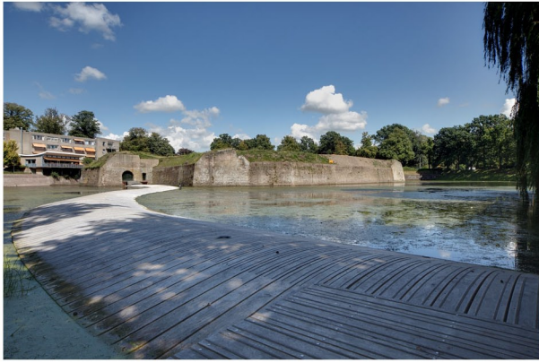
Brug Ravelijn, Bergen op Zoom, 2014, RO&AD Architecten.
